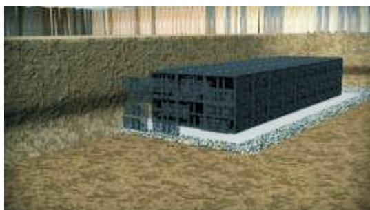
После того, как все блоки расположены, система полностью должна быть завернута в геотекстиль. Это предотвращает попадание частиц грязи в систему.
